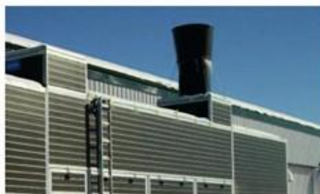
Топлообменител с 80% ефективност и намаляване на разходите за отопление
